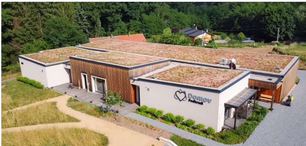
Obrázek 23: Inspirativní příklad – Domov pro seniory Podhradí – zelená střecha, pasivní budova, permakulturní sad a výhledově akumulční nádrže
