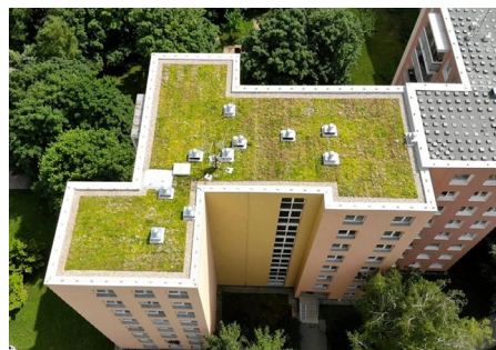
071 Příklad zelené střechy na panelovém domě. [ Brno ]
