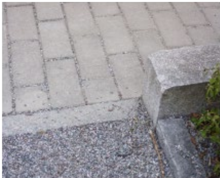
002 Maloformátová betonová dlažba
