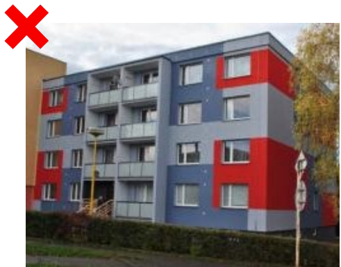
082 Barevné zpracování fasády by nemělo vytvářet architekturu budovy. Kombinace více sytých barev není vhodná. [ Valašské Meziříčí ]
