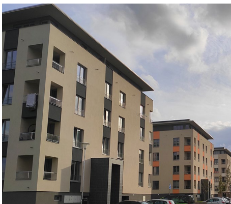
077 Lodžie s částečně vyzděným zábradlím. [ Chrudim, Na Špici ]
