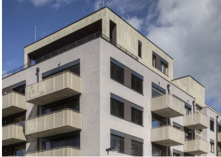
096 Kombinace hladké omítky na hlavní hmotě objektu a škrábané omítky s metalickým efektem na ustupujícím podlaží. [ Praha 10, Malešice ]
