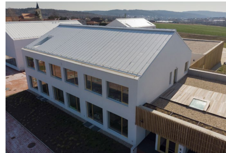
075.1 Šikmá bílá střecha s vysokým albedo efektem. Toto řešení snižuj efekt vzniku tzv. „městského tepelného ostrova“ ve městech a na předměstích.
