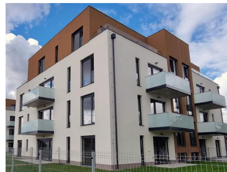
078 Neprůhledné skleněné zábradlí v kombinaci s průhledným sklem u francouzských oken a teras ustupujícího podlaží. [ Praha 8, Pekařova - Bohnice ]
