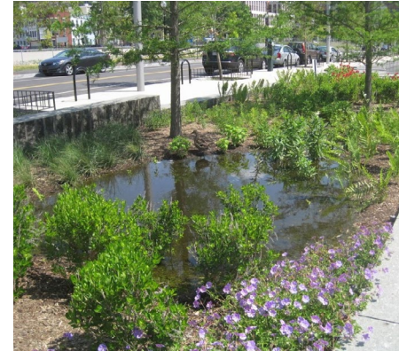
049 Dešťový záhon, díky své schopnosti retence srážkové vody plní jednu z hlavních funkcí adaptačních opatření v intravilánu dle adaptační strategie města Polička na změnu klimatu.
