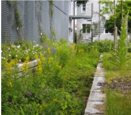
047 Vsakovací rýha s porostem trvalek vhodná pro umístění do uličního profilu. [ Německo ]
