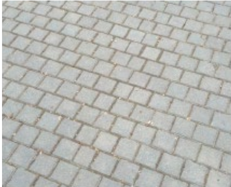
001 Maloformátová betonová dlažba
