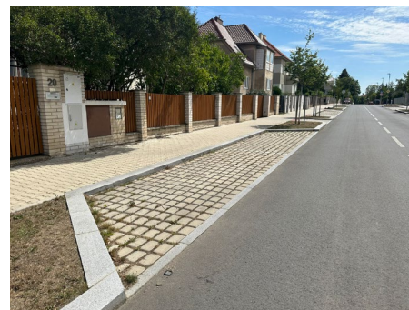
018 Podélné parkovací stání s využitím zatravňovací betonové dlažby s vhodně umístěnou solitérní zelení. [ Praha 4, Kunratice ]
