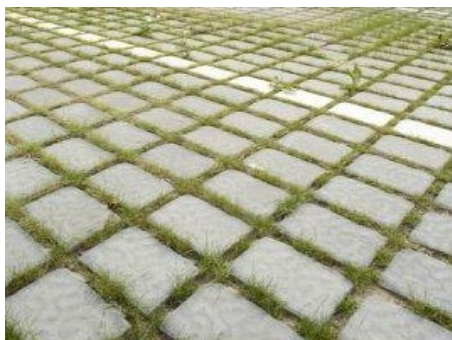
014 Zatravňovací betonová dlažba se spárou vyplněnou zeminou smíchanou s travním semenem
