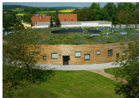
072 Příklad zelené střechy na objektu občanské vybavenosti - škola. [ Libeznice ]
