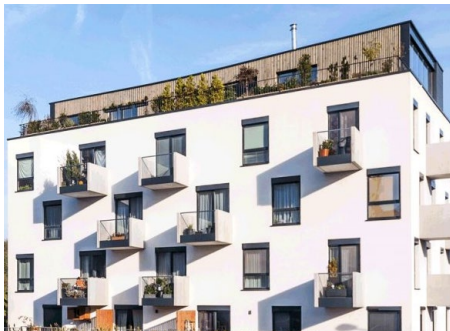
097 Ustupující podlaží s fasádou z vertikálně rastrovaného dřevěného obkladu z thermo borovice. [ Slovensko, Bratislava ]
