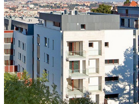
099 Ustupující podlaží tvořené deskovým materiálem v kombinaci s bílou omítkou. [ Praha 5, Smíchov ]
