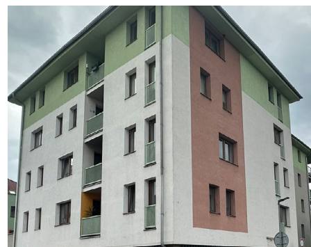
079 Kovové průsvitné zábradlí použité u lodžii a francouzských oken [ Lovosice ]
