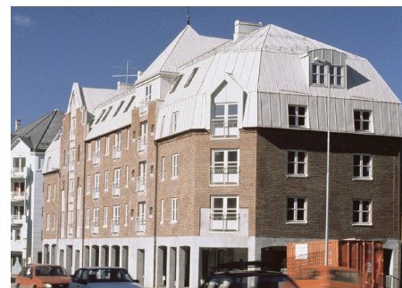
075.2 Šikmá bílá střecha.
