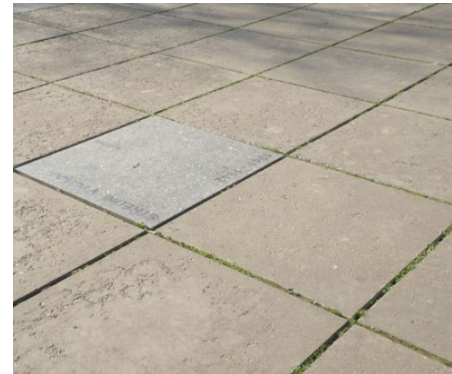
004 Velkoformátová betonová dlažba
