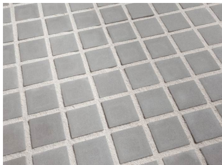
013 Zatravňovací betonová dlažba se spárou vyplněnou drobným kamenivem
