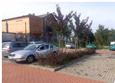
Využití polopropustných a propustných povrchů, květinových záhonů a dřevin na parkovišti u Městského pivovaru. Příklad dobré praxe
