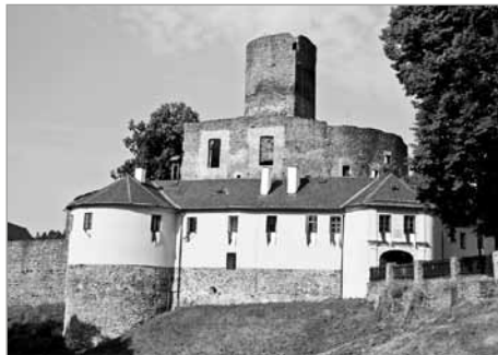
Vstupní průčelí zdobí slavnostní prapory
