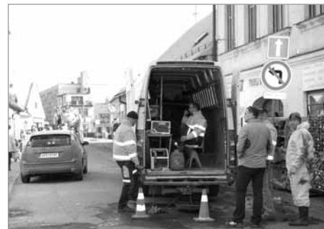
Oprava kanalizace probíhá bezvýkopovou technologií
