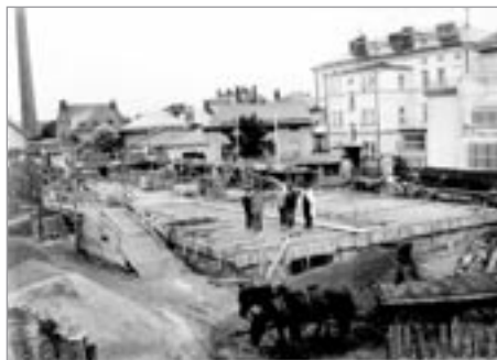
Stavba infekčního pavilonu v srpnu 1938
