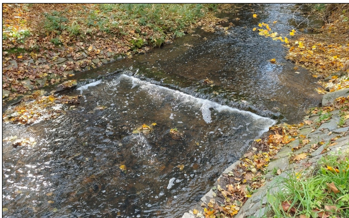
Obr. 52 – Drobné vodní stupně na Křetince netvořící významnou migrační bariéru
