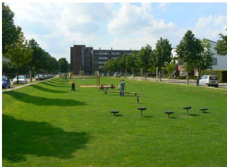
042 Integrované řešení — pobytová louka plní roli zasakovacího průlehu. [ Nizozemí, Nijmegen ]
