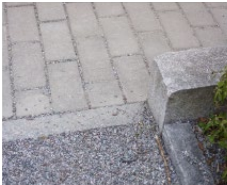
002 Maloformátová betonová dlažba
