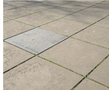
004 Velkoformátová betonová dlažba
