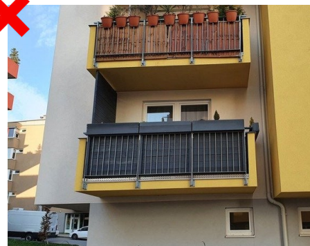
080 Zábradlí s tyčovou výplní není vhodné, často dochází k uživatelským úpravám a to narušuje vizuální kompaktnost objektů.
