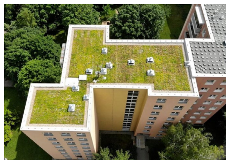
071 Příklad zelené střechy na panelovém domě. [ Brno ]
