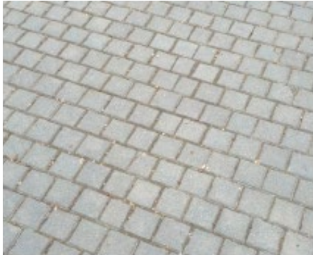
001 Maloformátová betonová dlažba
